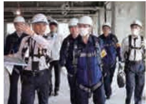
建設現場の安全パトロール (全国安全週間を契機とした取組の一環)
